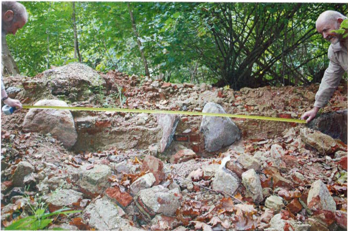
48 Pav. Šiaurės-rytų kampo pamatai. 2011-09-08
