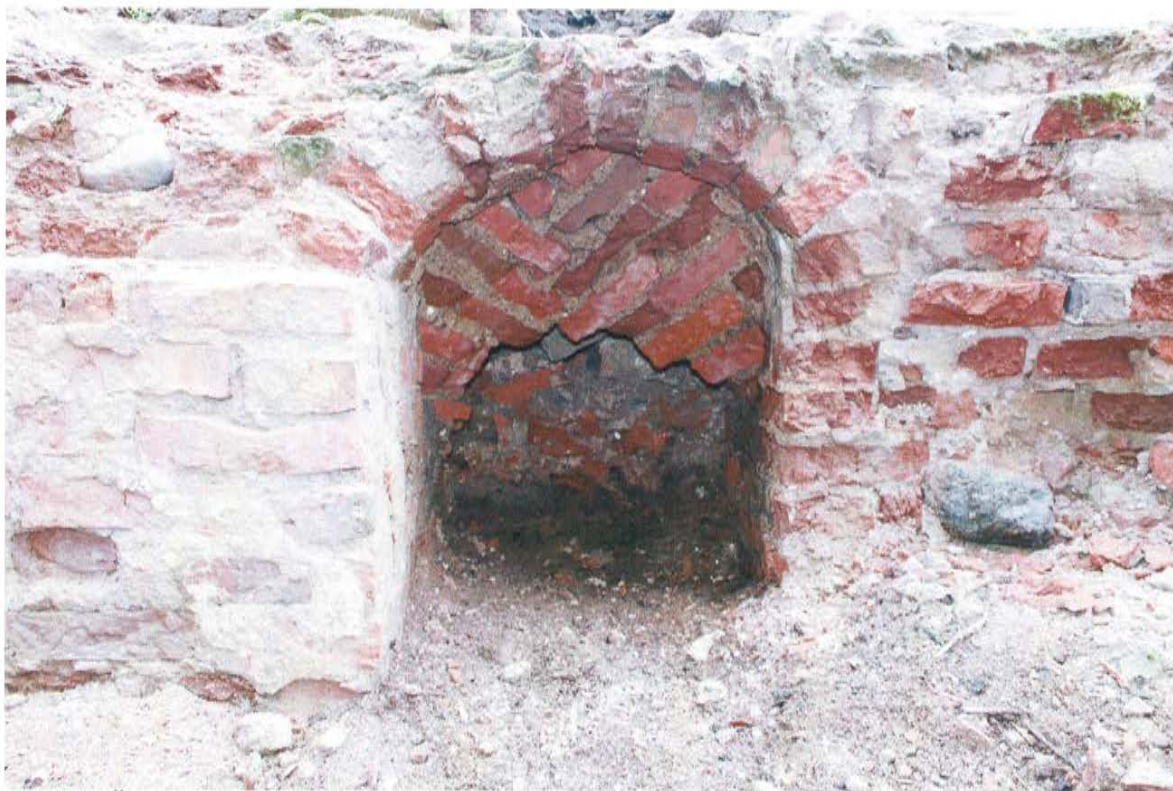
26 Pav. Šiaurinėje sienelėje esantis vakarinis švieslangis. 2012 m. Rugsėjis
