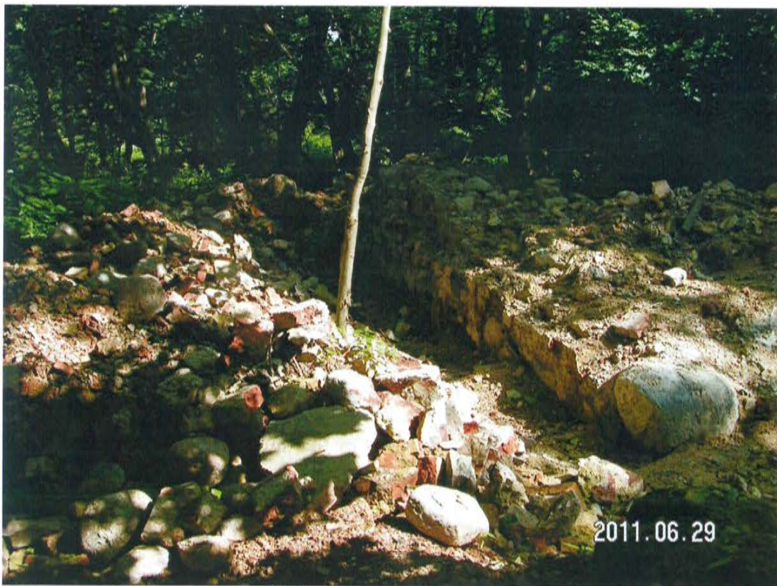
36 Pav. Atidengtų pamatų vakarinė pusė.
