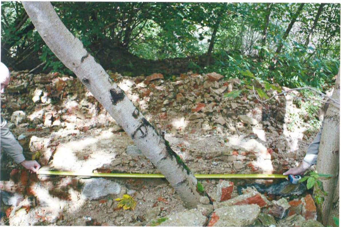
44 Pav. Pietryčių kampo pamatai. 2011-09-08
