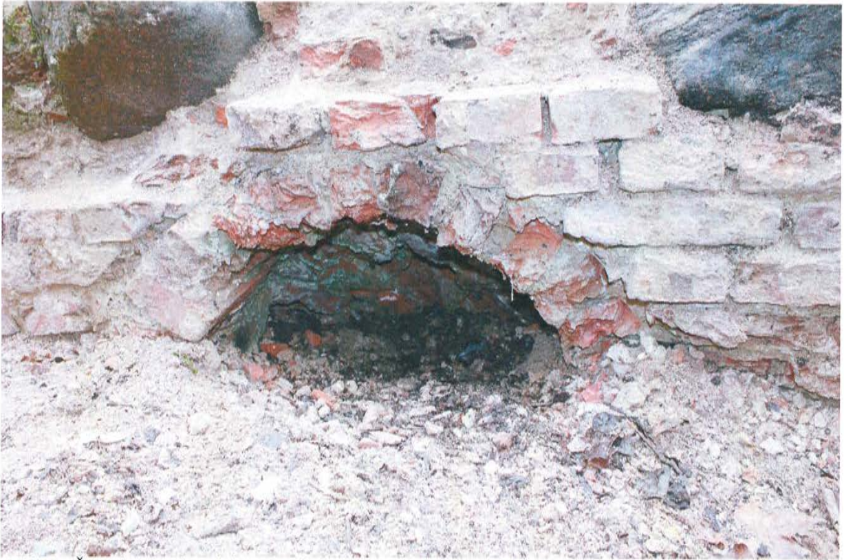
27 Pav. Šiaurinėje sienelėje esantis rytinis švieslangis. 2012 m. Rugsėjis
