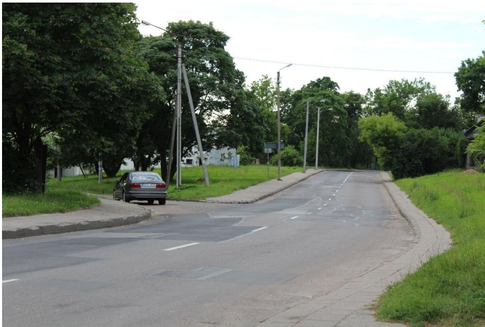
Pav. 5 Projektuojamo kabelio vieta Rasų gatvėje iš R
