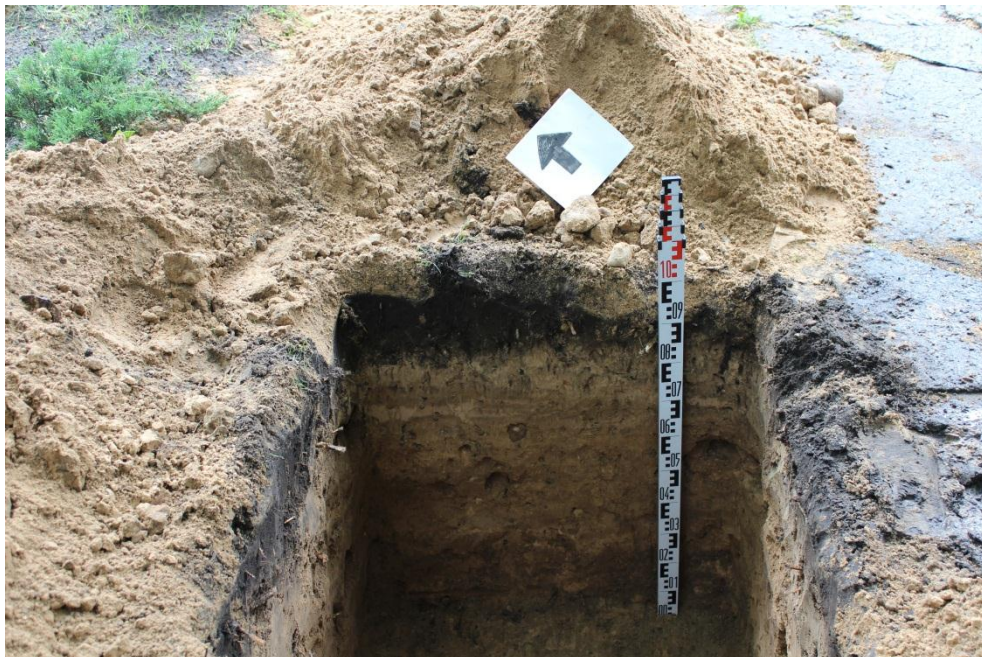
Pav. 16 Šurfo Nr. 8 ŠR sienelė iš PV
