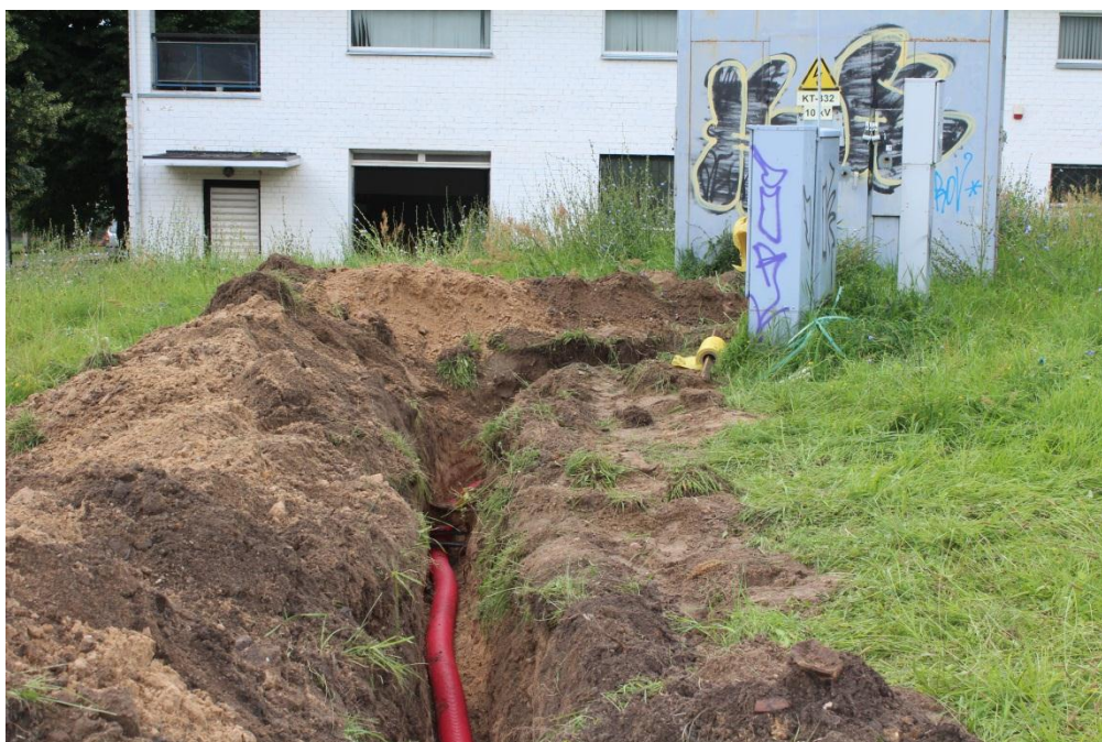
28 Pav. 36 Žvalgyta kabelio vieta Rasų gatvėje prie transformatorinės
