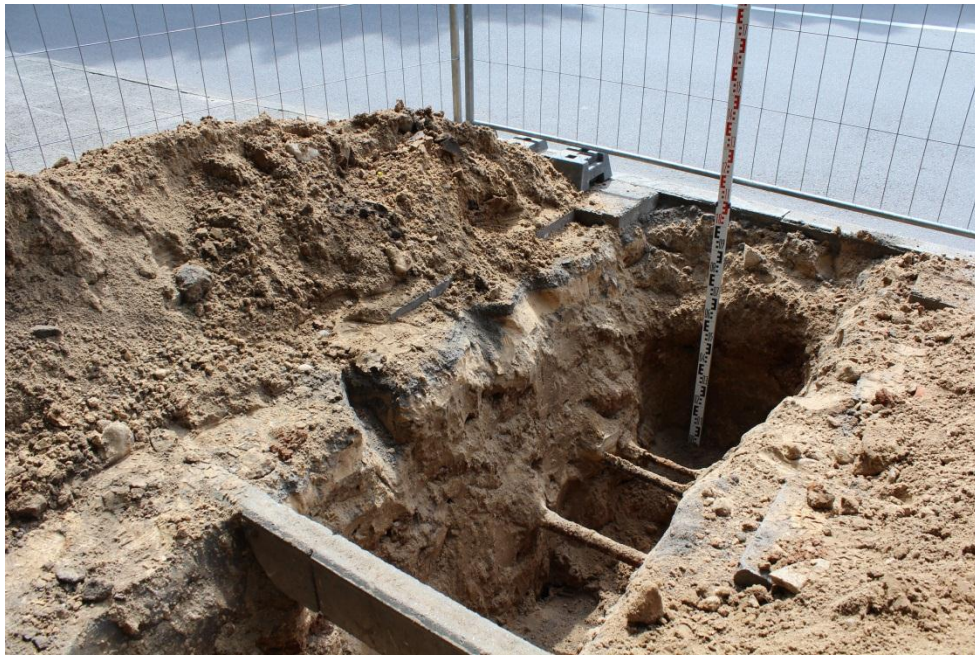
Pav. 31 Žvalgyta kabelio vieta Rasų gatvėje
