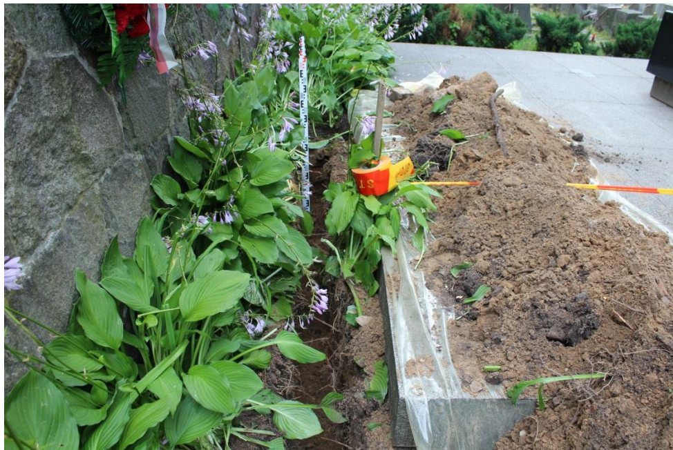
Pav. 28 Žvalgyta kabelio vieta kapinių teritorijoje už paminklo
