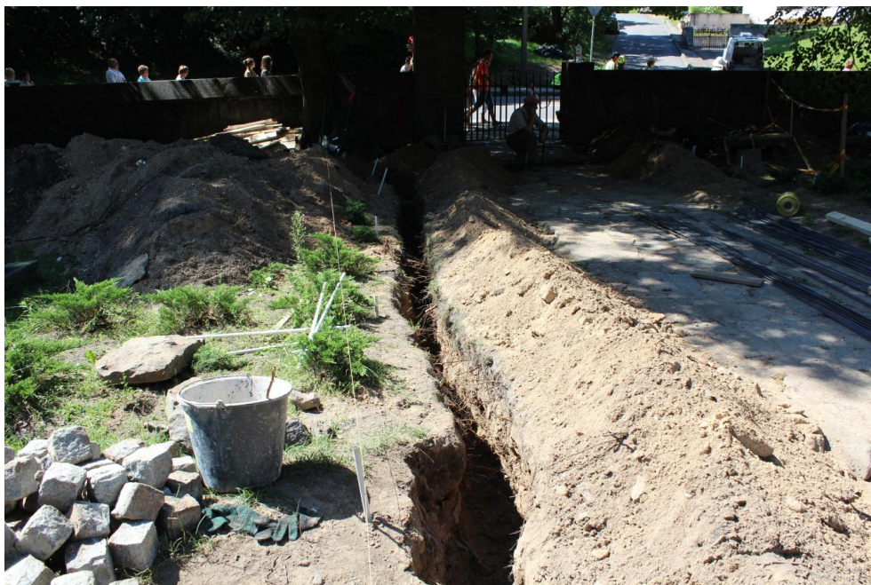
Pav. 42 Žvalgyta kabelio vieta kapinių teritorijoje
