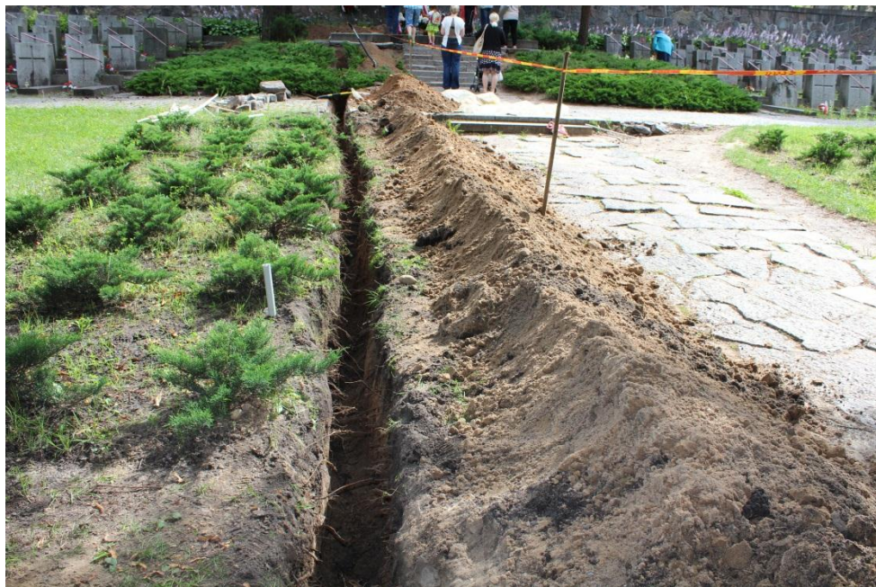
Pav. 29 Žvalgyta kabelio ir šviestuvų vieta kapinių teritorijoje
