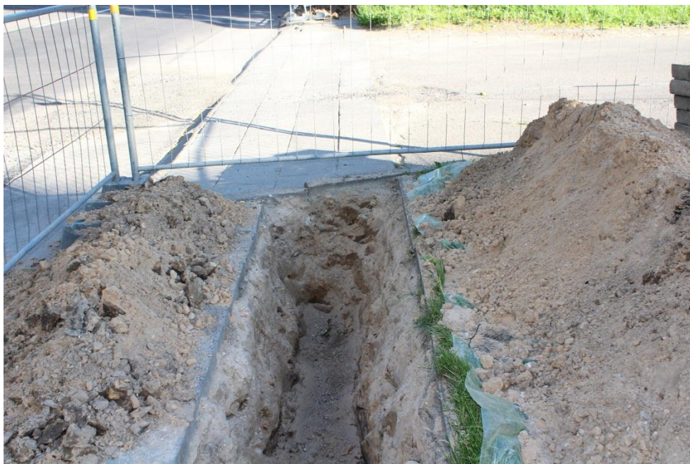
Pav. 32 Žvalgyta kabelio vieta Rasų ir Varšuvos gatvių sankryžoje
