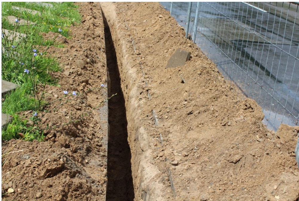
Pav. 34 Žvalgyta kabelio vieta Rasų gatvėje
