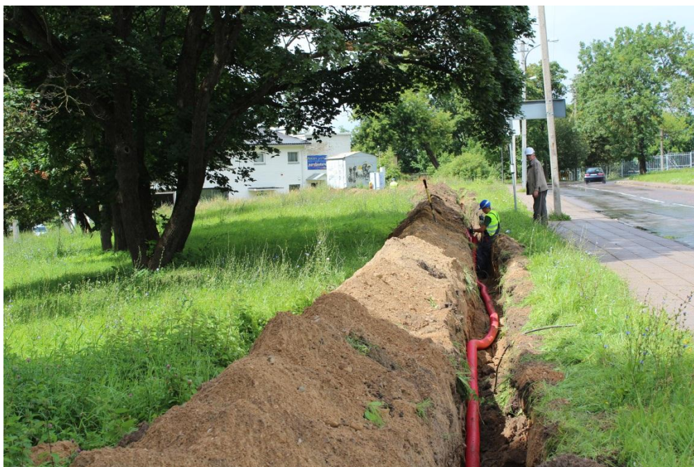
Pav. 35 Žvalgyta kabelio vieta Rasų gatvėje
